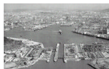
<인천항의 갑문(閘門)>
